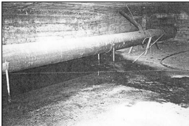
Bild 4: Undichte Entwässerungsleitung.
