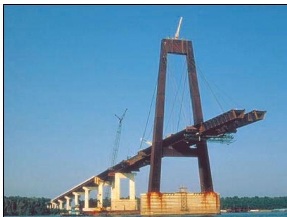
Bild 3.17 Luling-Brücke in Louisiana [Int 2004e].
