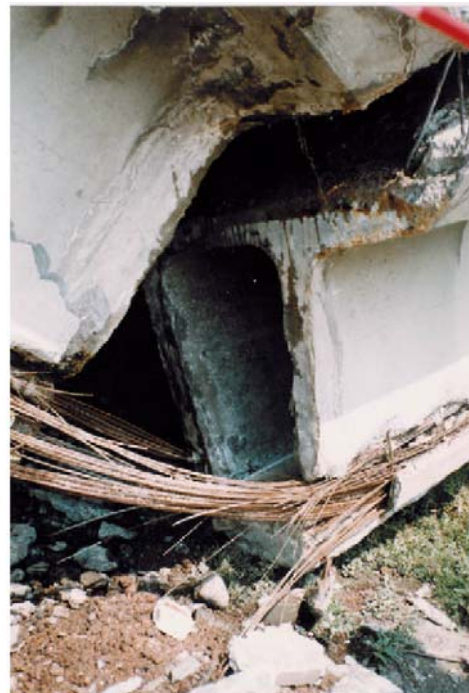
Bild 2.42 Zerstörter Längsträger der Brücke San Stefano, Sizilien [Proverbio 2000, 2001].
