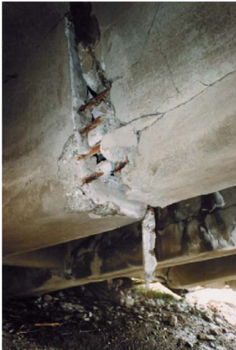
Bild 2.42 Zerstörter Längsträger der Brücke San Stefano, Sizilien [Proverbio 2000, 2001].
