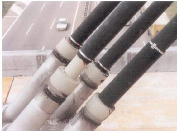
Bild 2: Muffenbereich unten.
