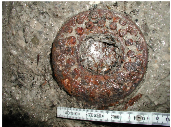
Bild 2.38 Brücke Oberföhringerstrasse über den Mittleren Ring München-Bogenhausen (Baujahr 1959): a) frei gestrahlte Spannverankerungen; das Abdeckplättchen, des obersten linken Spannankers fehlte gänzlich. Die Abdeckplättchen, die das Herauslaufen des noch nicht erhärteten zementösen Füllgutes nach dem Verpressvorgang hätten verhindern sollen, waren häufig verbogen oder fehlten ganz. Das Füllgut war in diesen Fällen im oberen Bereich des Ankerkopfes nicht vorhanden, d.h., die oberen Spannglieder waren nicht mit Füllgut umgeben, sondern lagen frei und b) freigelegter Spannanker mit deutlichen Korrosionsschäden [Sodeikat 2004].
