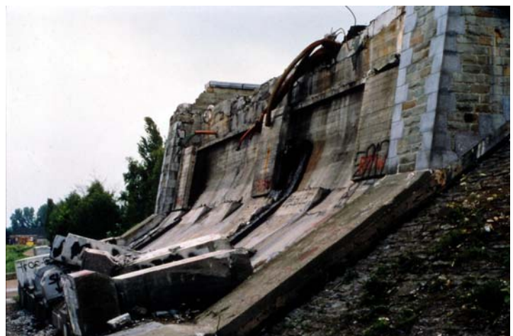
Bild 2.48 Details der Brücke über die Melle bei Gent, Belgien, nach dem Einsturz (Ministère Wallon de l'Équipement et des Transports).
