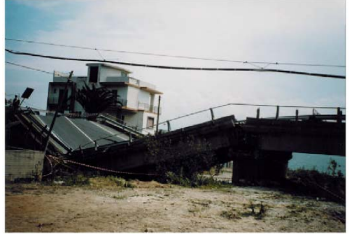
Bild 2.40 Brücke San Stefano, Sizilien: Baujahr 1956, Einsturz 1999 [Proverbio 2000, 2001].
