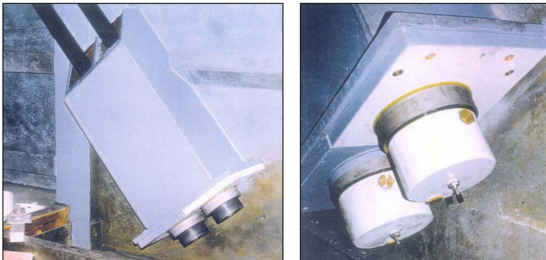
Bild 6: Unterer Verankerungsbereich (Schutzhauben mit Messanschluss).
