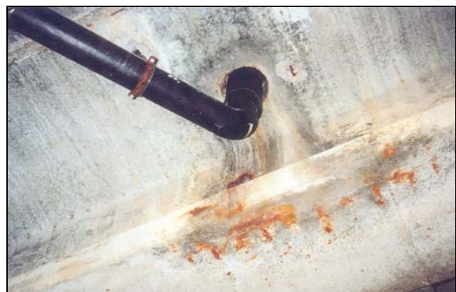
Bild 2: Undichte Entwässerungsleitung.
