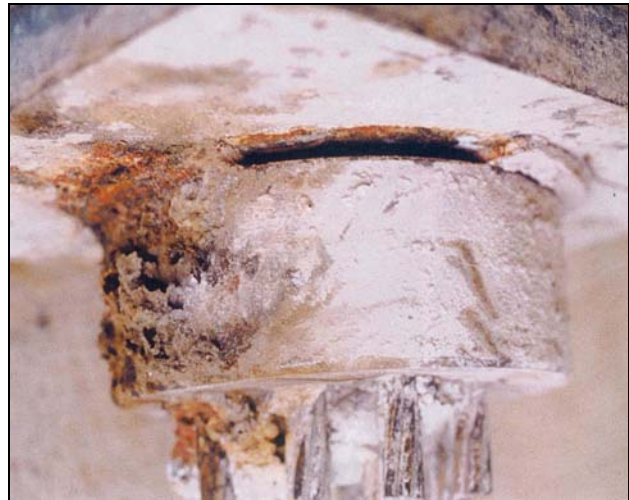
Bild 6: Spalt zwischen Ankerbüchse und –platte.
