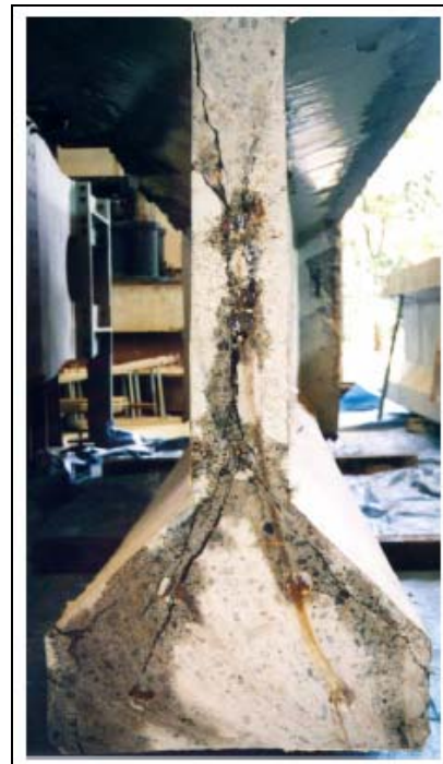
Bild 2.63 Kuretsubo-Brücke: a) Ergebnisse der Zustandsuntersuchung der Spannglieder im Bereich des Spanngliederversagens und b) Ansicht des Trägers mit innerem Riss [Tanaka 2004].
