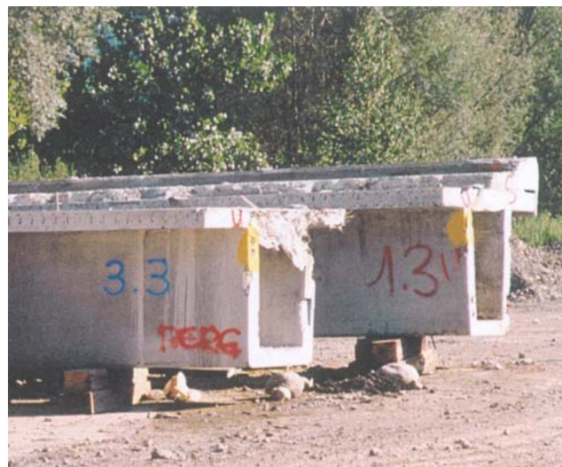
Bild 2: Zwei vorgefertigte Hohlkastenträger (nach dem Abbruch auf der Deponie).
