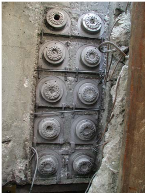
Bild 2.37 Brücke Seehauszufahrt am Mittleren Ring in München-Schwabing (Baujahr 1963): a) Spannanker mit Lochfrasskorrosion an den Spanndrahtenden und der Ankerkonstruktion infolge Tausalzangriff und b) Ausgebauter und aufgeschnittener Spannanker. Die Spanndrähte vor der Klemmung (nicht lastabtragender Bereich) waren stark durch Lochfrass geschädigt, im Bereich der Klemmung und hinter der Klemmung (lastabtragender Bereich) waren keine Korrosionsschäden mehr erkennbar [Sodeikat 2004].
