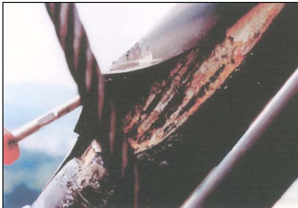
Bild 4: Öffnen des Spannliedes.
