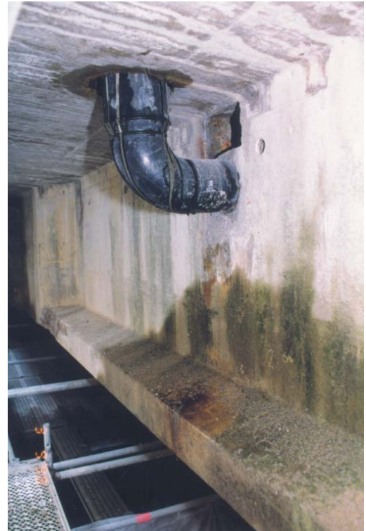
Bild 2.24 a) Wasserlauf entlang dem Steg eines vorgefertigten Elementträgers ( BE-14 ), b) Wasserantritt aus Belags- bzw. Abdichtungsentlüftungsröhrchen ( ZH-08 ) und c) undichte Entwässerung [Hunkeler 1998]).
