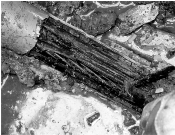
Bild 3: Hinter der Mauer frei gegrabener und geöffneter Anker. Keine sichtbaren Korrosionsschäden.
