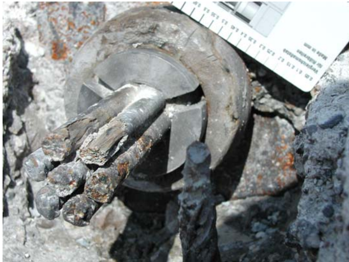
Bild 2.37 Brücke Seehauszufahrt am Mittleren Ring in München-Schwabing (Baujahr 1963): a) Spannanker mit Lochfrasskorrosion an den Spanndrahtenden und der Ankerkonstruktion infolge Tausalzangriff und b) Ausgebauter und aufgeschnittener Spannanker. Die Spanndrähte vor der Klemmung (nicht lastabtragender Bereich) waren stark durch Lochfrass geschädigt, im Bereich der Klemmung und hinter der Klemmung (lastabtragender Bereich) waren keine Korrosionsschäden mehr erkennbar [Sodeikat 2004].
