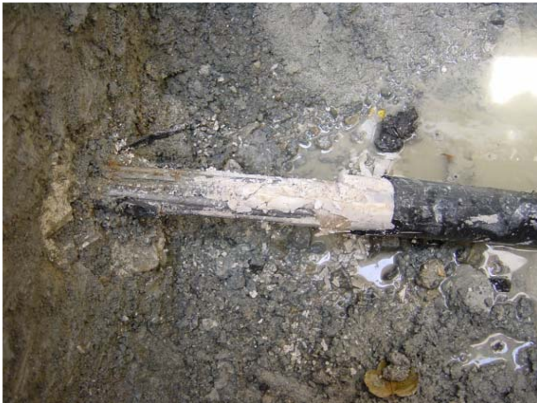
Bild 8: Sicht auf den freigelegten Anker Nr. 52 der Mauer Nr. 46.
