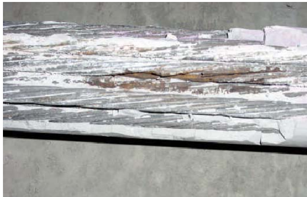
Bild 2.76 Korrosion an Ankerköpfen und Korrosionsschäden an den Litzen der Mid-Bay-Brücke [FDOT 2001b].
