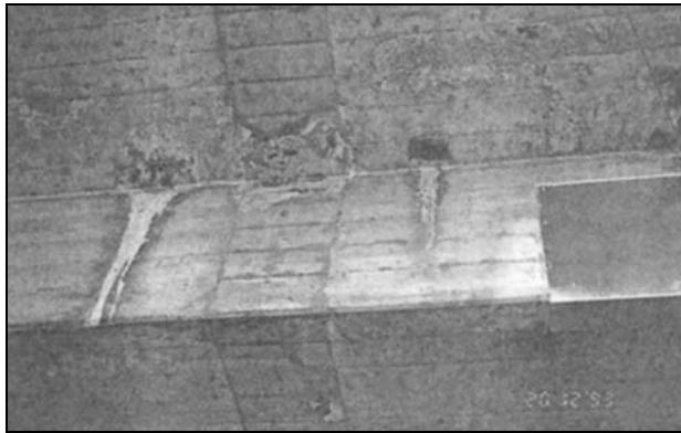
Bild 2: Spuren der Wasserläufe entlang der Stegaussenseite.
