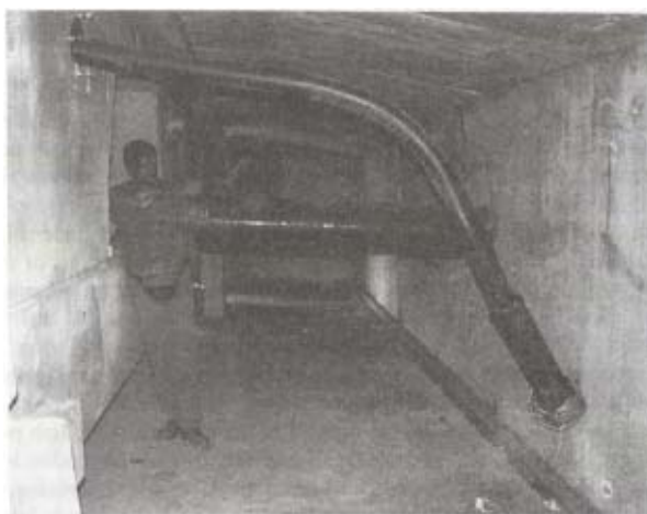
Bild 2.72 a) Gerissenes Spannglied der Brücke Rivière d'Abord und b) Zustand der Litzen bei der Bruchstelle [Godart 2001].
