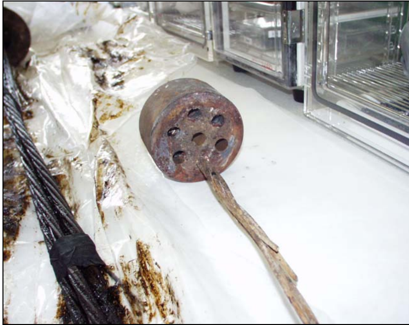
Bild 10: Spannkopf des Normalankers mit einer darin verbliebenen Litze im Anlieferungszustand.
