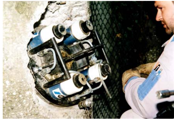
Bild 4: Spezielle Presse zum Abheben des Ankerkopfes ohne Gewinde.
