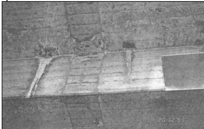
Bild 2.24 a) Wasserlauf entlang dem Steg eines vorgefertigten Elementträgers ( BE-14 ), b) Wasserantritt aus Belags- bzw. Abdichtungsentlüftungsröhrchen ( ZH-08 ) und c) undichte Entwässerung [Hunkeler 1998]).
