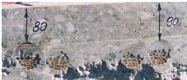
Bild 2.34 Beispiele zur Lage von Spanndrähten in Spanngliedern.
