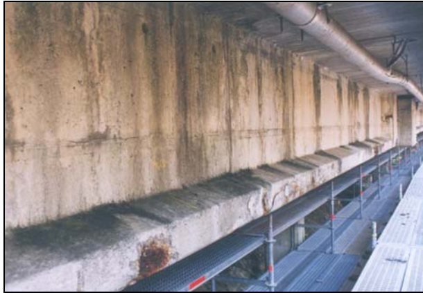
Bild 2: Wasserläufe.
