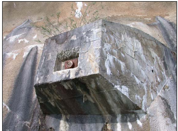
Bild 4.24 Risse im Beton einer Verankerung wegen der Alkali-Aggregat-Reaktion und dadurch Wassereintrag in den Ankerkopfbereich und Korrosion am Ankersystem.
