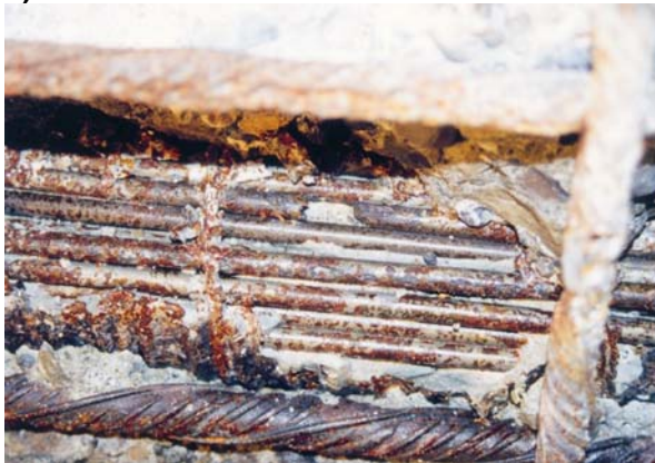
Bild 2.27 a) Intakter und stark korrodierter Spanndraht [Vogel 2002], b) Lochfrass an Spanndrähten und ein durchgerosteter/gerissener Draht und c) oberflächliche Korrosion an Litzen ( SO-07 ).
