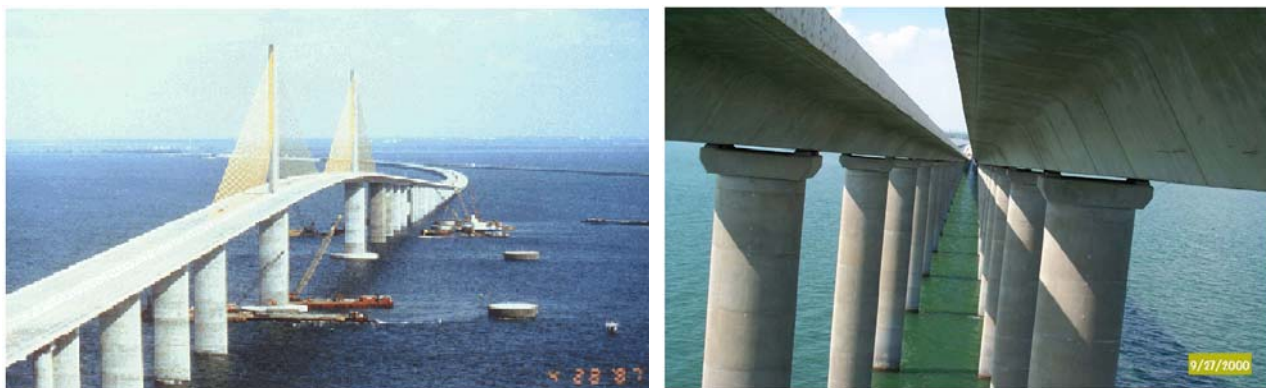
Bild 2.57 Ansichten der Sunshine Skyway Bridge in der Tampa Bay, Florida [Theryo 2002].
