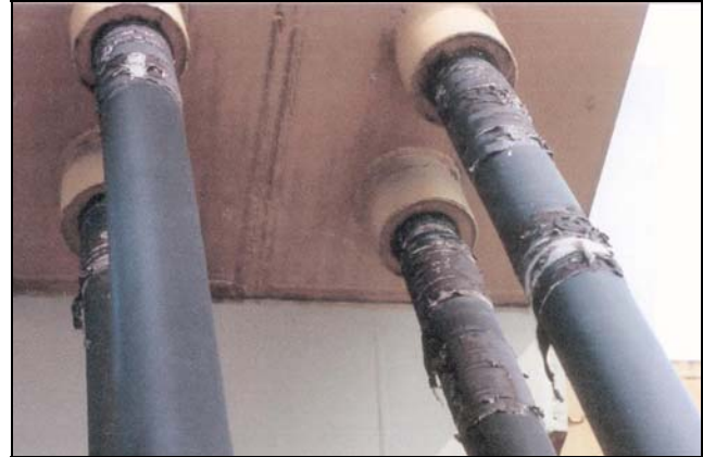
Bild 3: Muffenbereich oben (mit versprödeten Bandagen).
